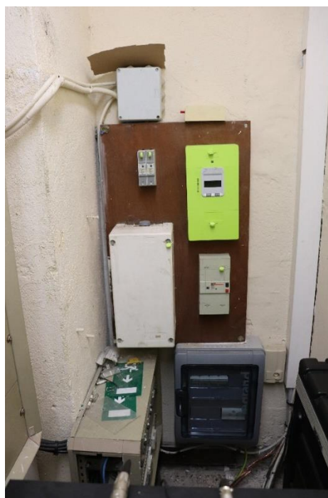
Compteur et disjoncteur de branchement – Parafoudre
